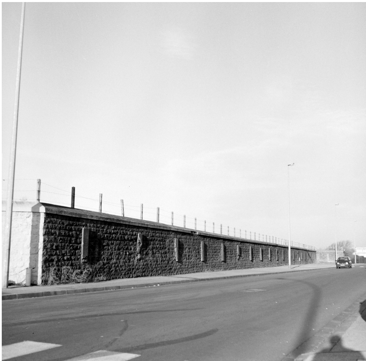
Façade rue d'Ambleteuse.
