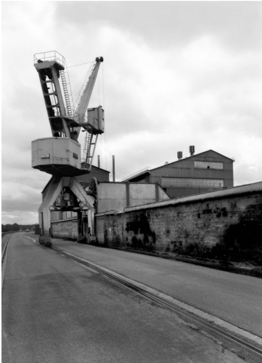
Grue située sur le quai d'Aval.
