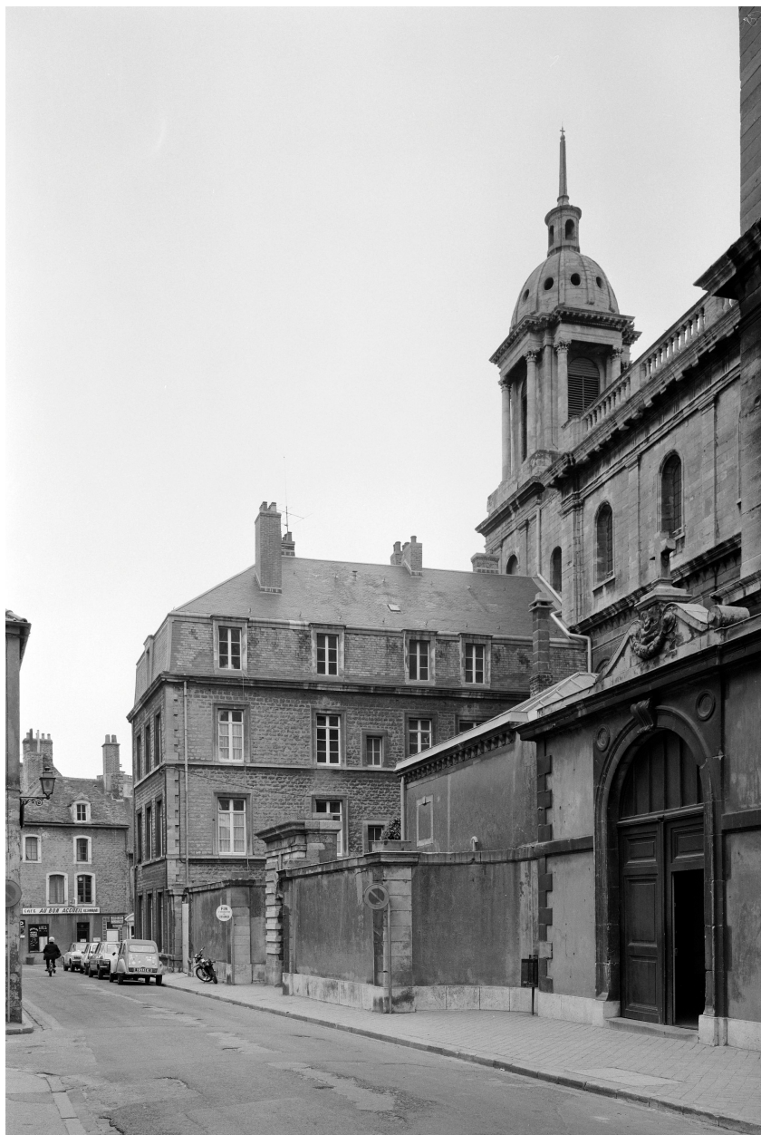
Presbytère, vue d'angle sud-est.
