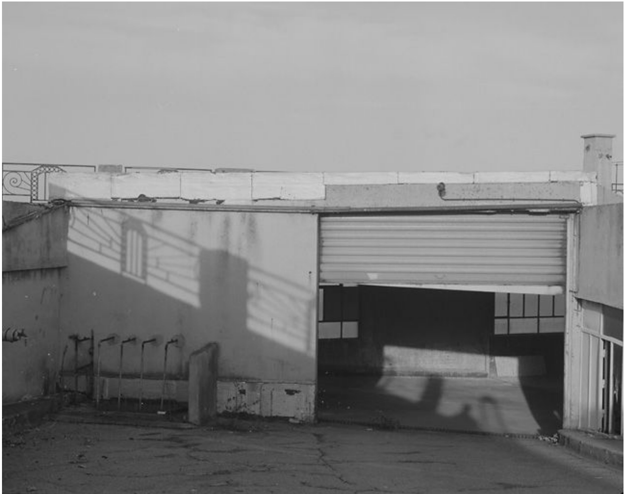
Vue de la sortie de garage sur la terrasse.
