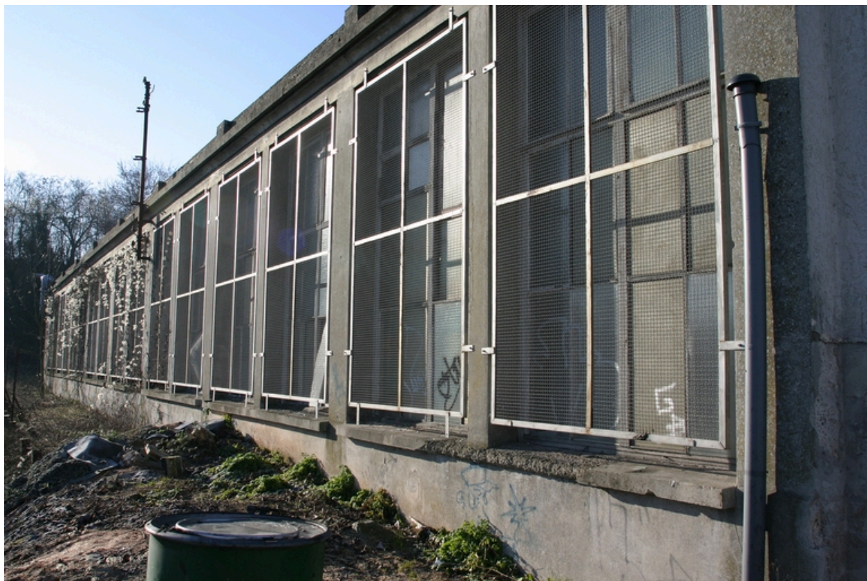
Façade latérale de l'atelier de tuft.
