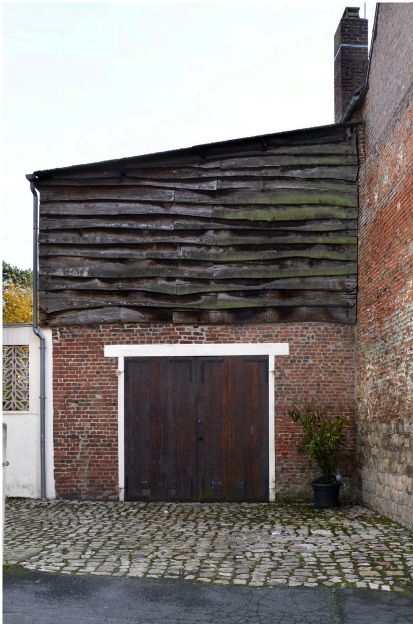
Garage dont la partie haute est couverte à clins - 13, rue Brancion.
