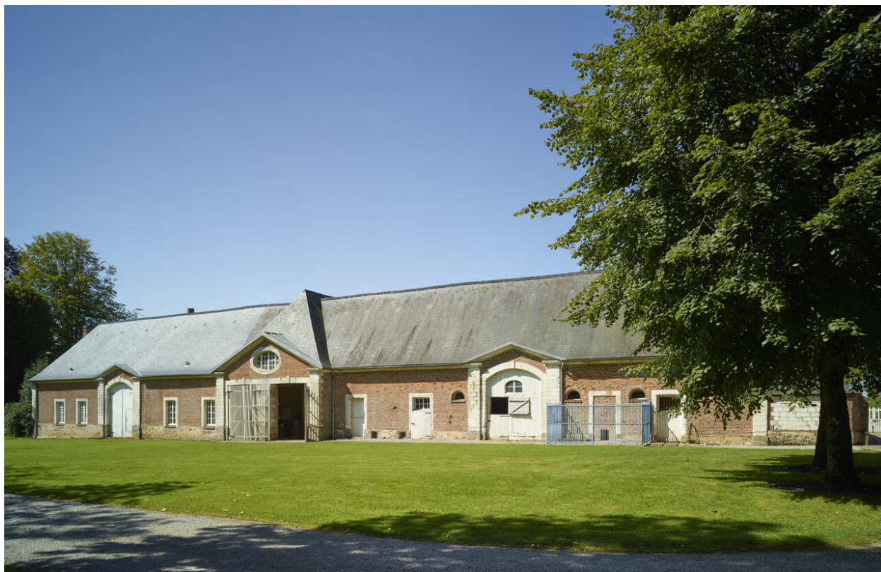
Vue générale du grand bâtiment des communs à l'ouest du château.
