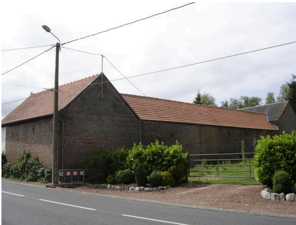
Vue générale latérale.
