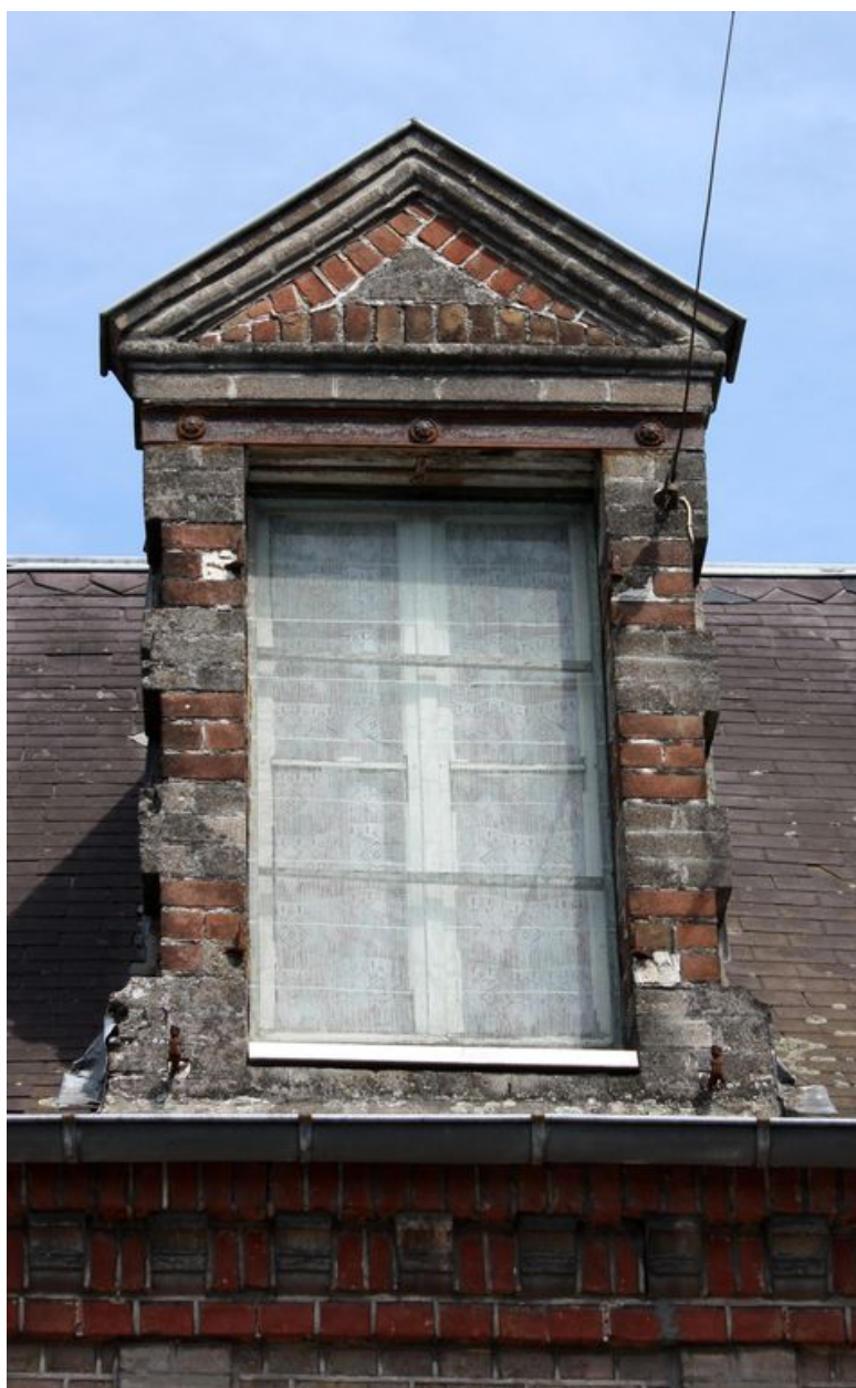
Maison, 24 rue Marius-Sire. Vue de la lucarne.
