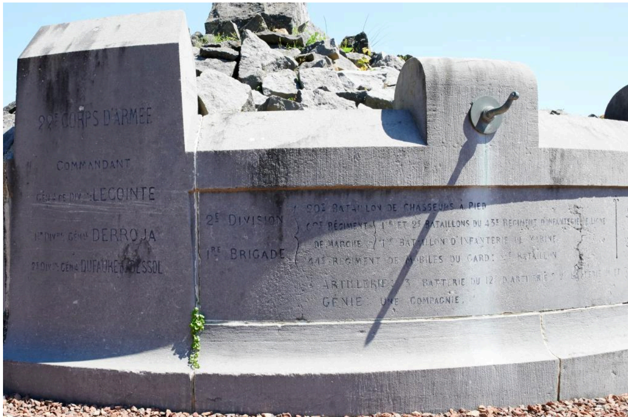
Vue de détail du panneau latéral 2 (numérotation depuis le panneau central avant dans le sens des aiguilles d'une montre).
