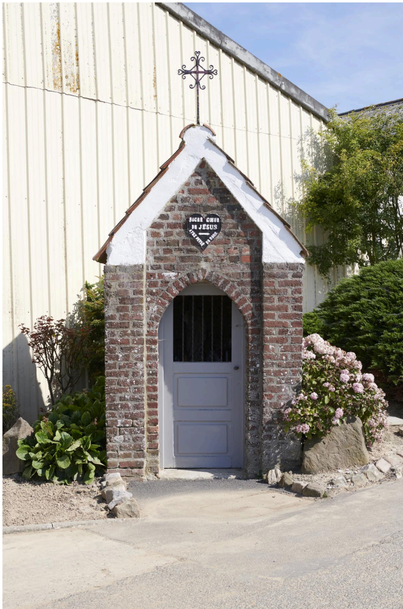
Façade principale de la chapelle.
