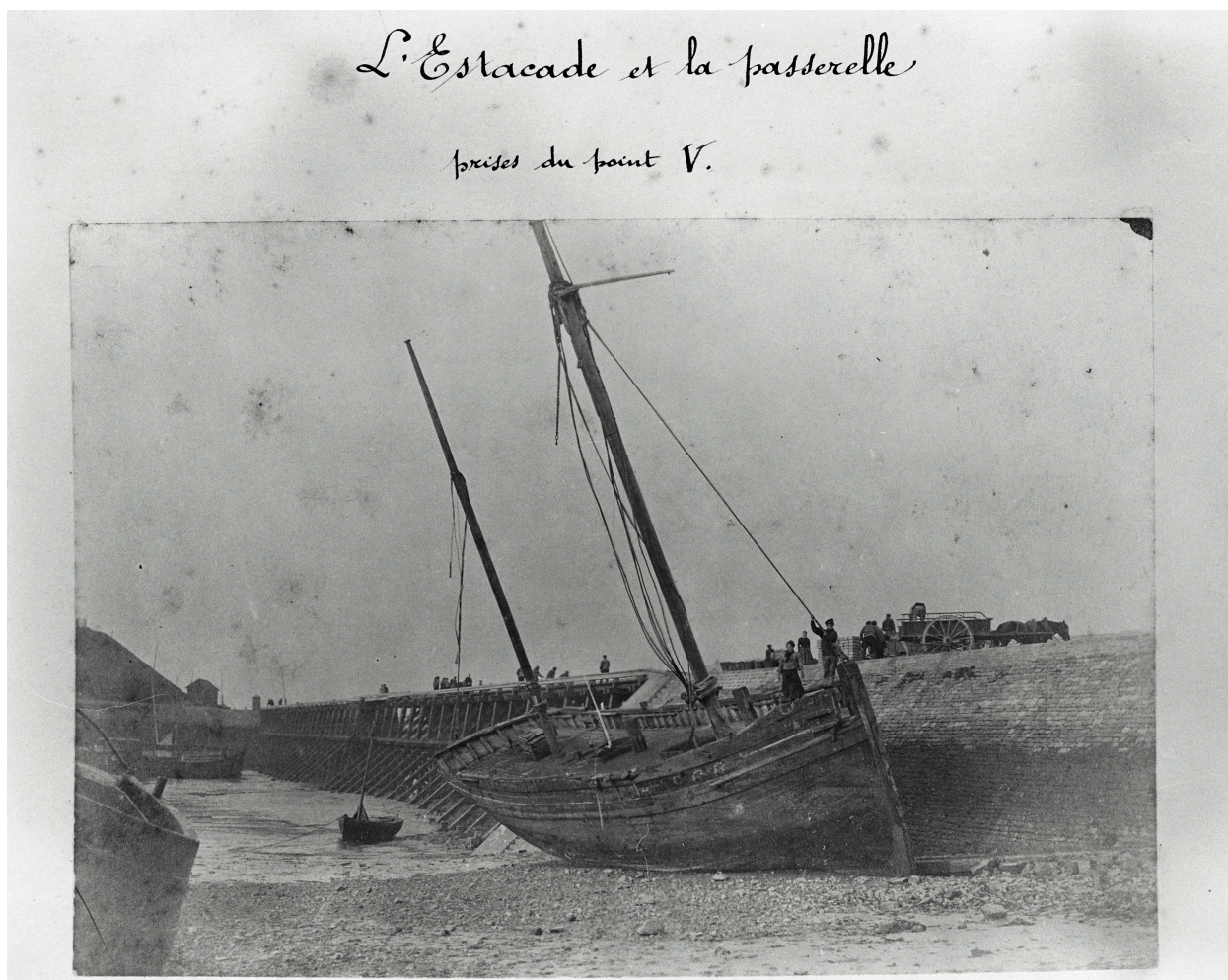
L'estacade et la passerelle, cliché. A.C. Boulogne-sur-Mer, clichés 1900.
