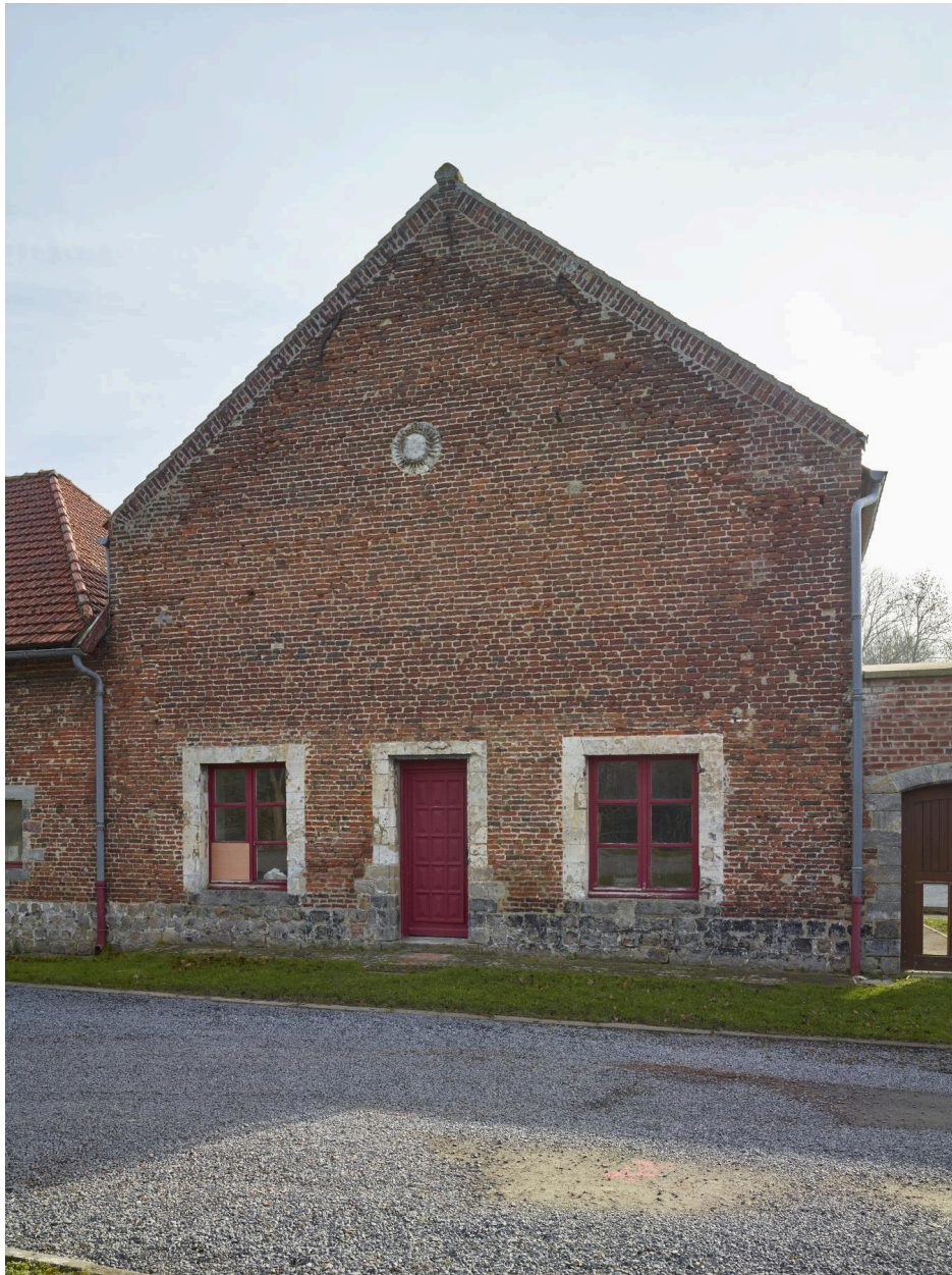
Mur-pignon du bâtiment sud-ouest. Vue prise depuis la rue.
