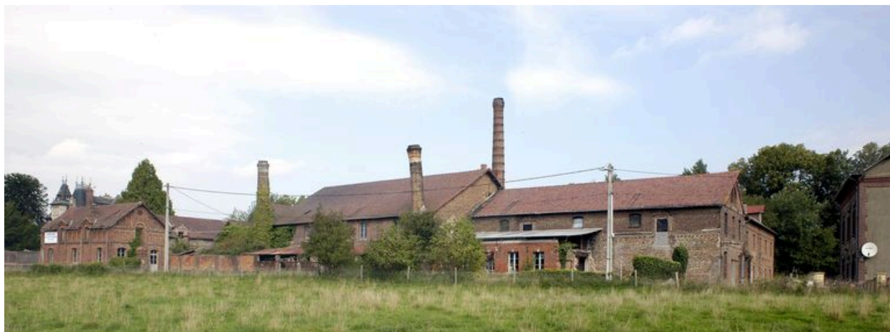
Vue d'ensemble de l'usine.
