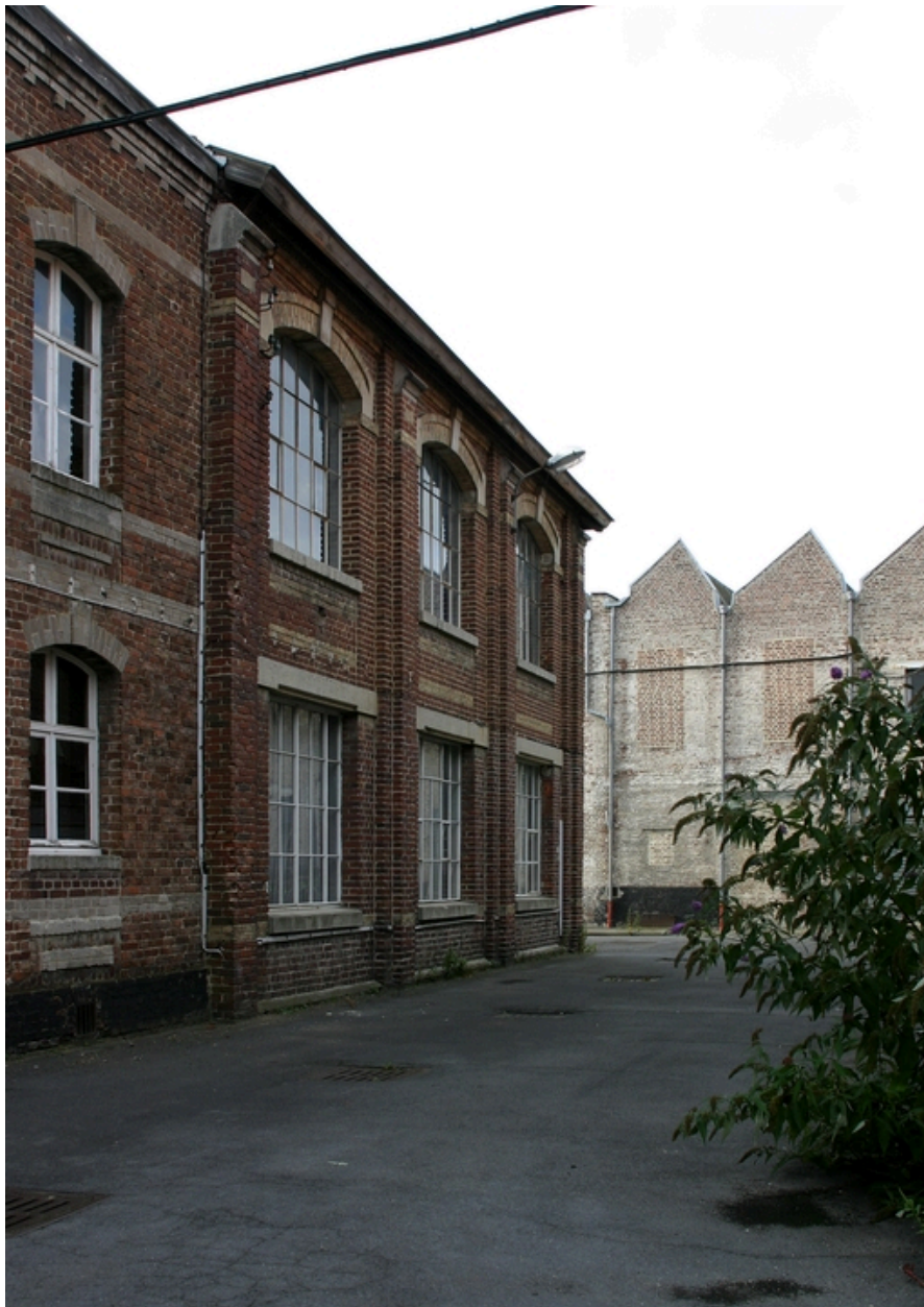
Pignon nord des bureaux.
