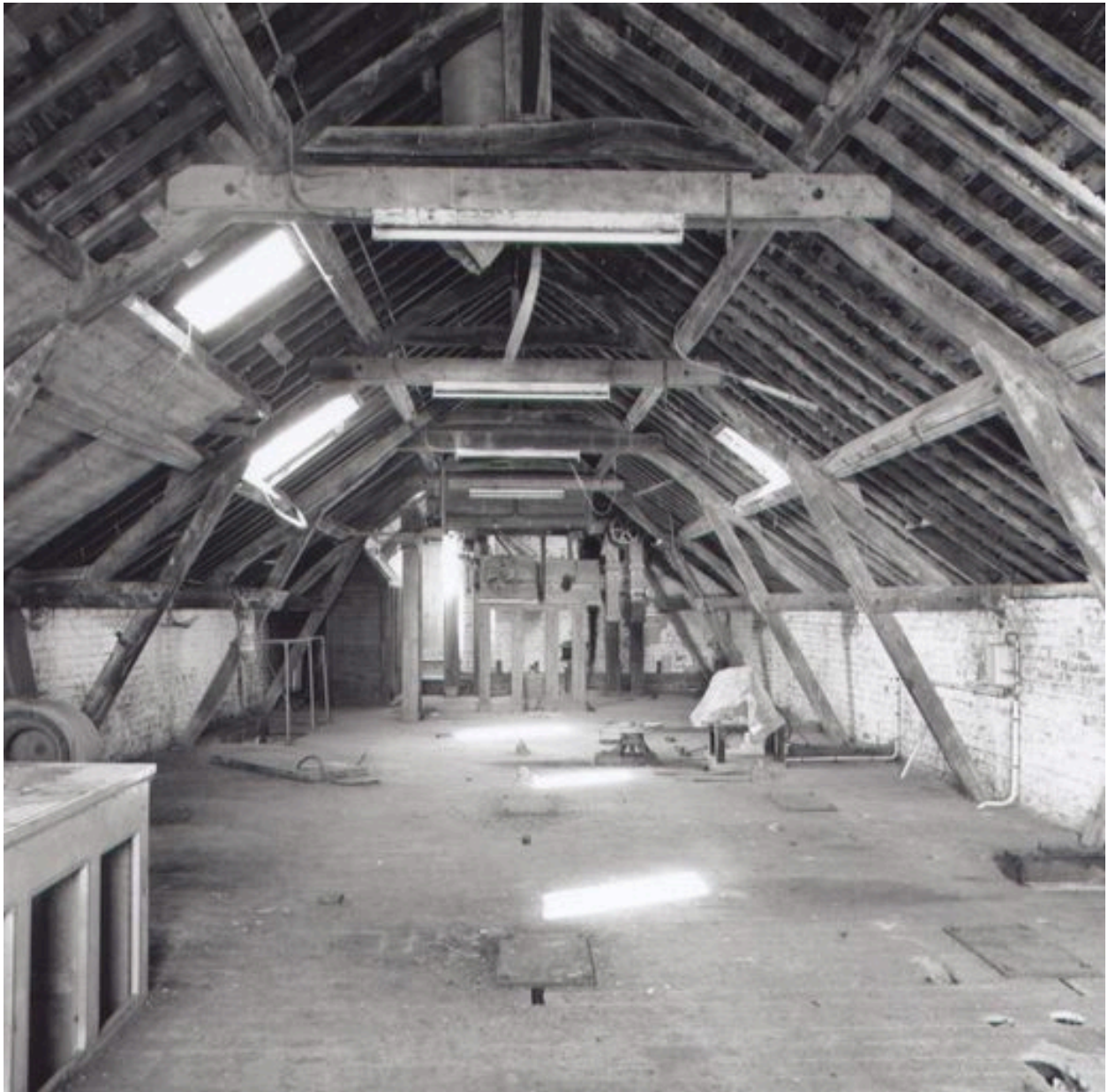
Vue intérieure des combles de la minoterie.
