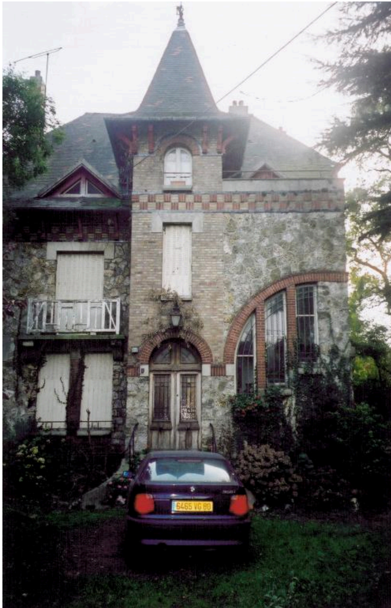
Vue de la façade principale de la maison, en 2003.
