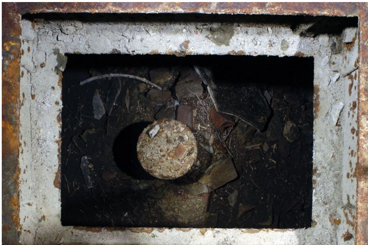
La turbine hydraulique, vue de dessus.
