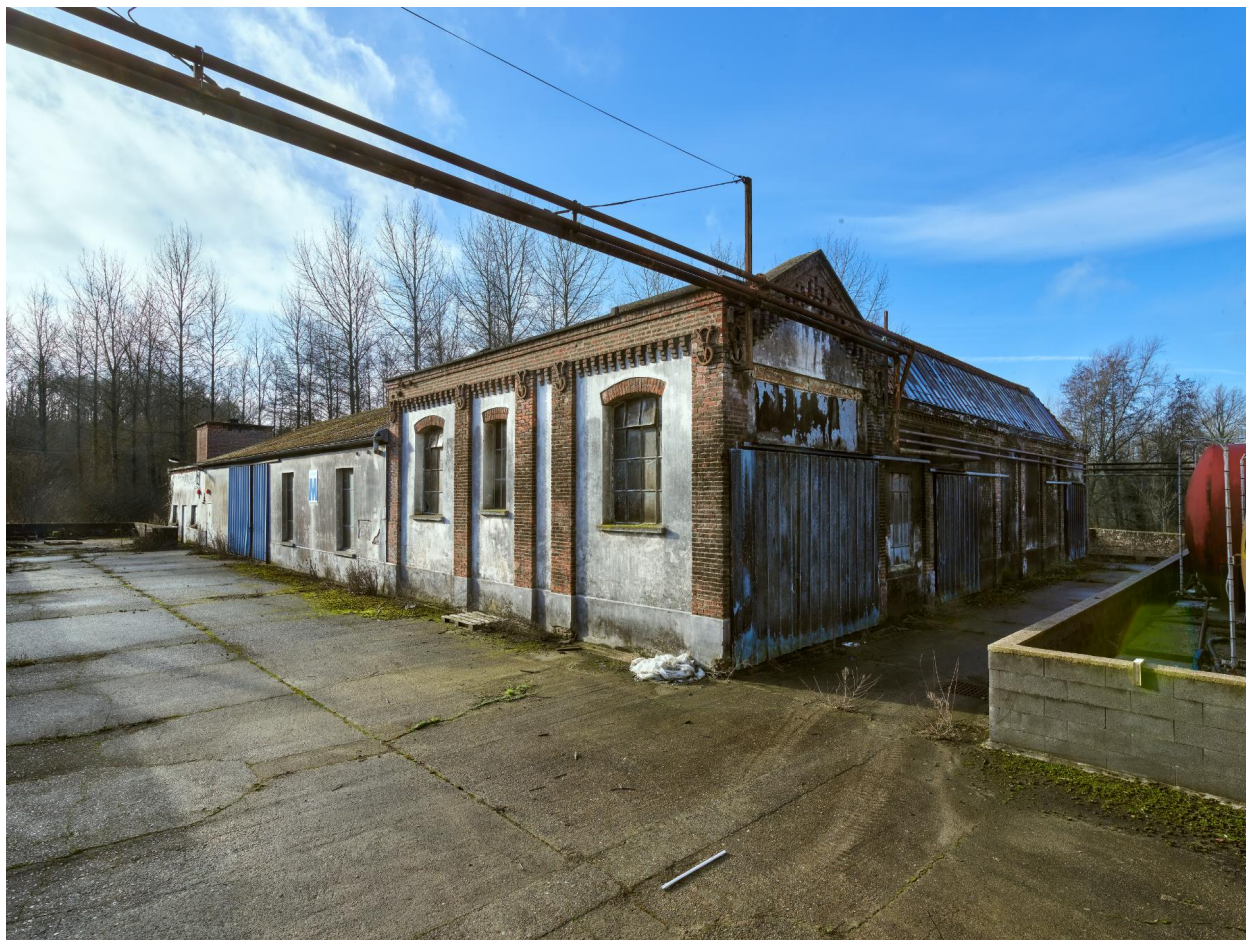
Vue générale nord-est d'un atelier (bâtiment M).
