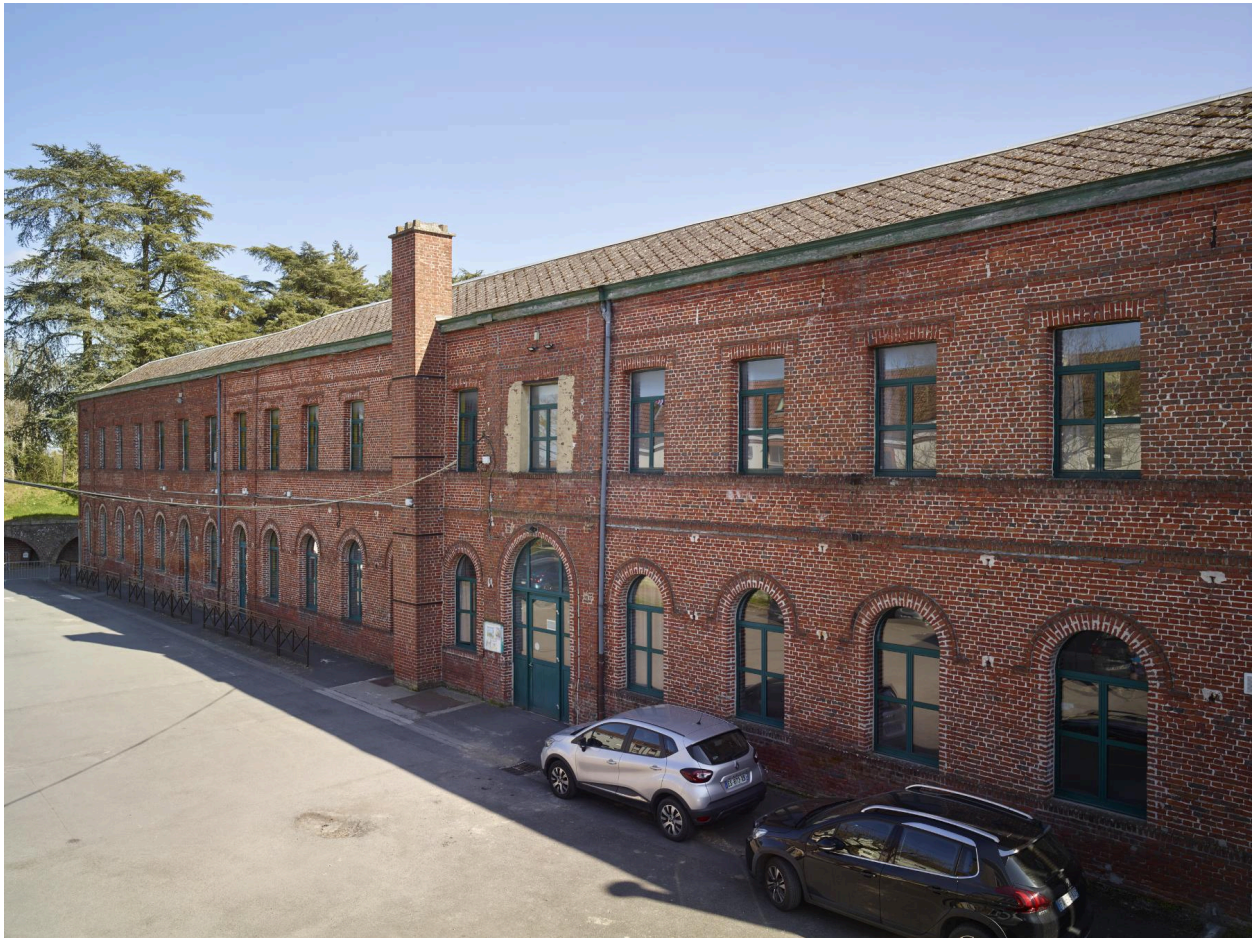
École de garçons : façade sur l'ancienne cour du collège du bâtiment construit en 1850 par l'architecte Casimir Pétiaux pour abriter les dortoirs du collège. Vue générale orientée sud-ouest/nord-est.
