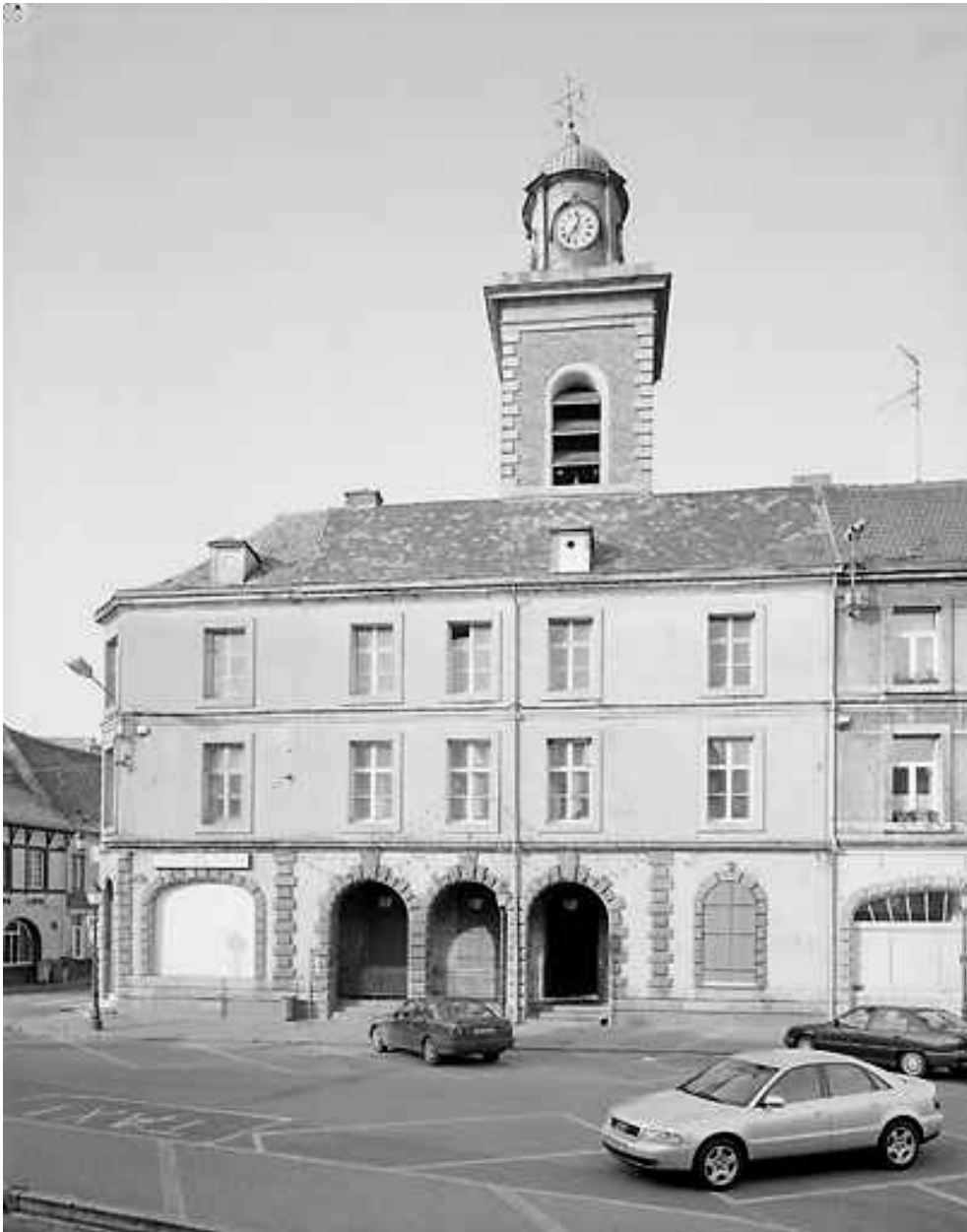
Corps de garde et beffroi : vue générale de face ; état en 2001.
