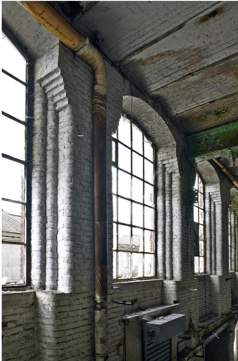
Vue intérieure de la filature (le plancher du rez-de-chaussée surélevé a été supprimé). Détails d'un trumeau.
