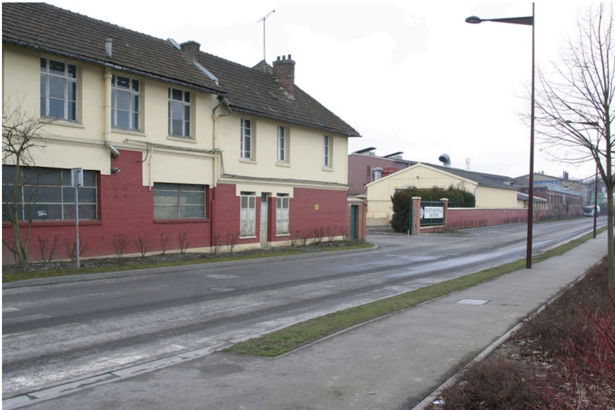
Entrée de l'usine.
