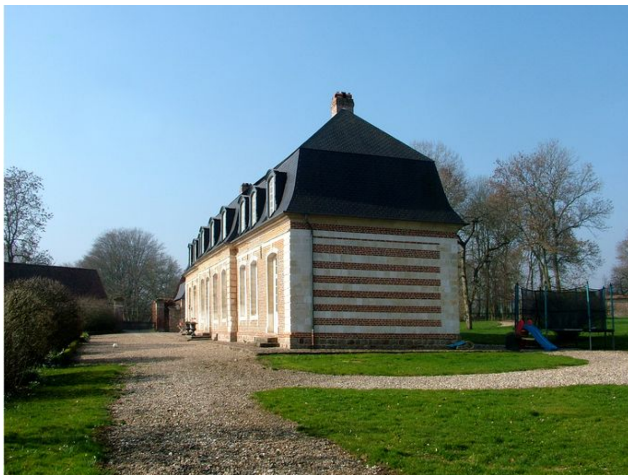
Vue latérale du logis.
