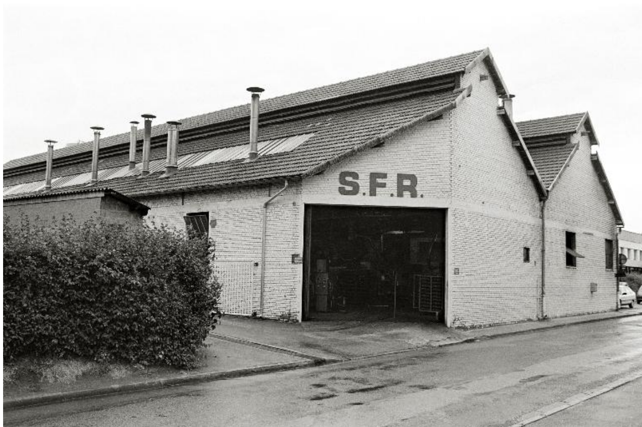
Ateliers de fabrication (1960), élévation antérieure en 1990.
