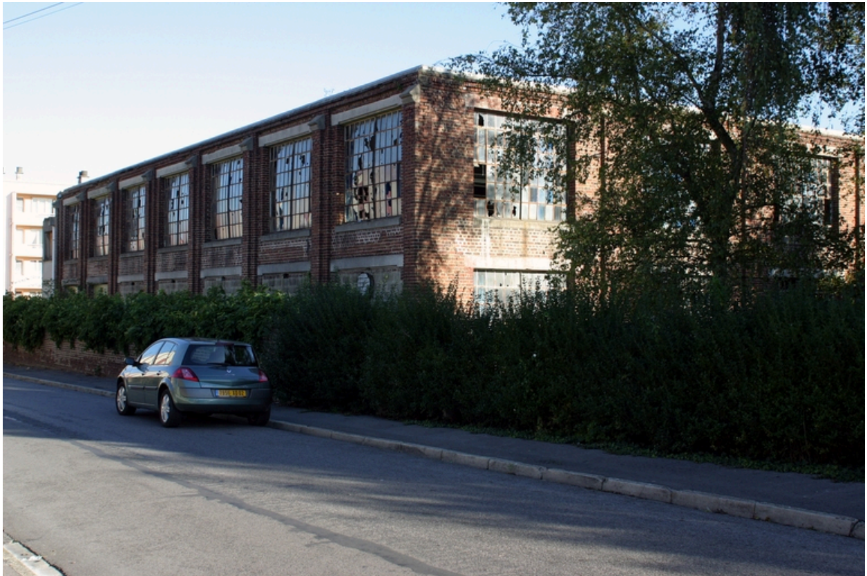
Ateliers à deux niveaux datant de la reconstruction : vue depuis la rue Jacky-Tabar.
