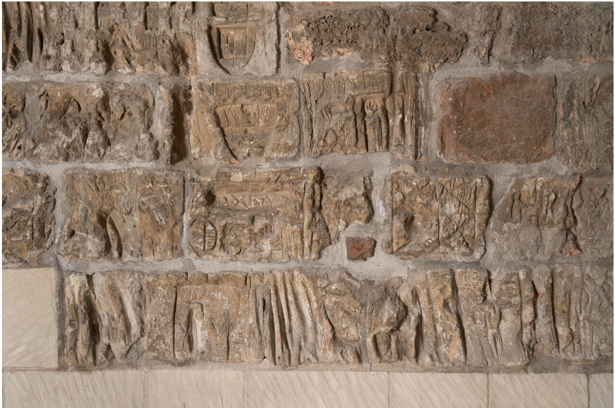
Détail d'un mur présentant des graffiti.
