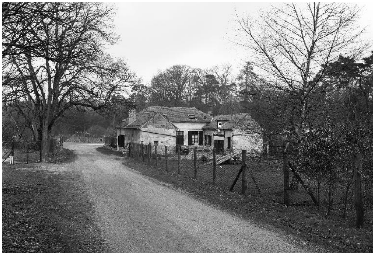
Vue générale sud.
