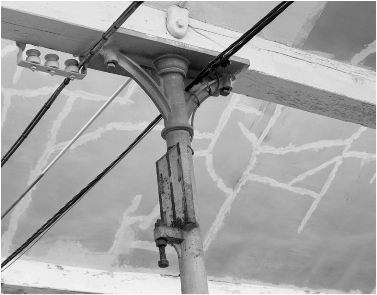
Détail d'un support métallique de la couverture de l'atelier de fabrication.
