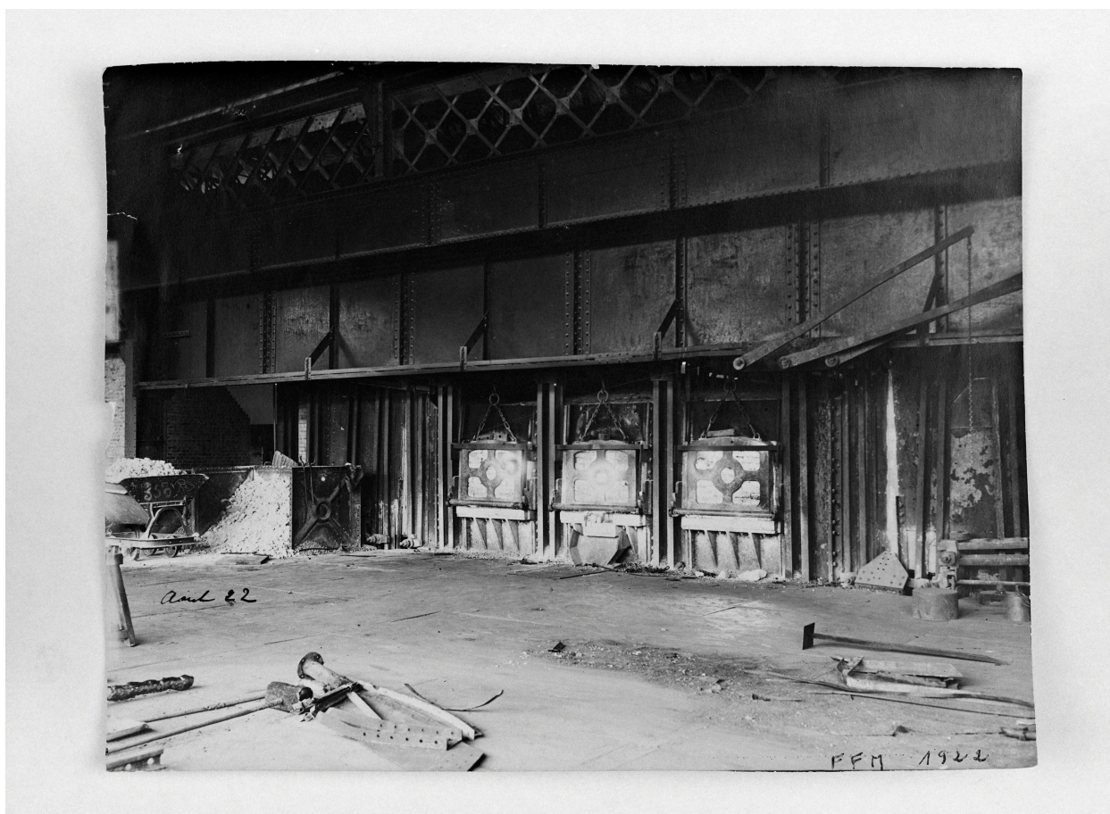
Ancien petit four de l'aciérie Martin, photographie ancienne, auteur inconnu, 1922 (coll. part.).
