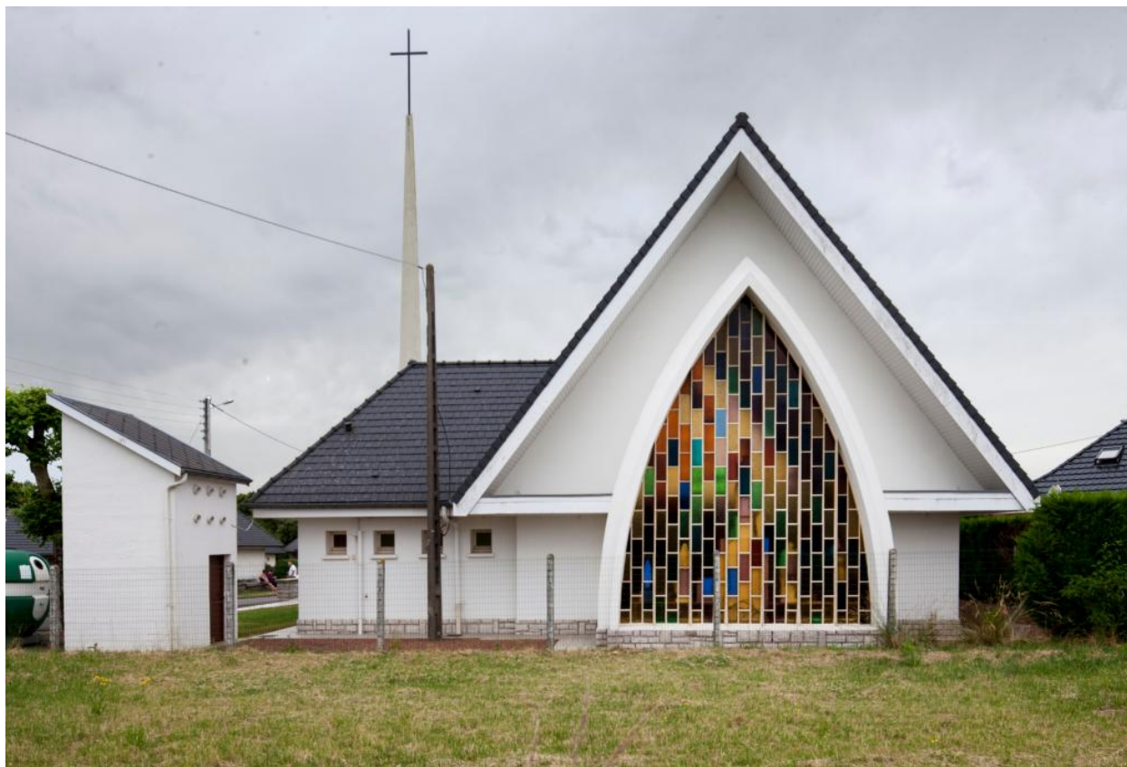
Élévation postérieure, vers l'ouest.
