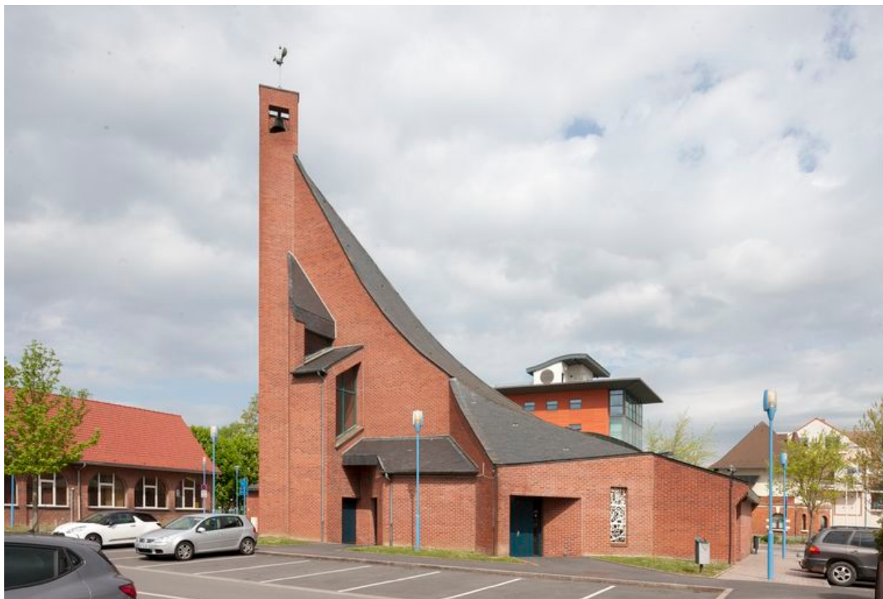
Vue générale prise du sud est.
