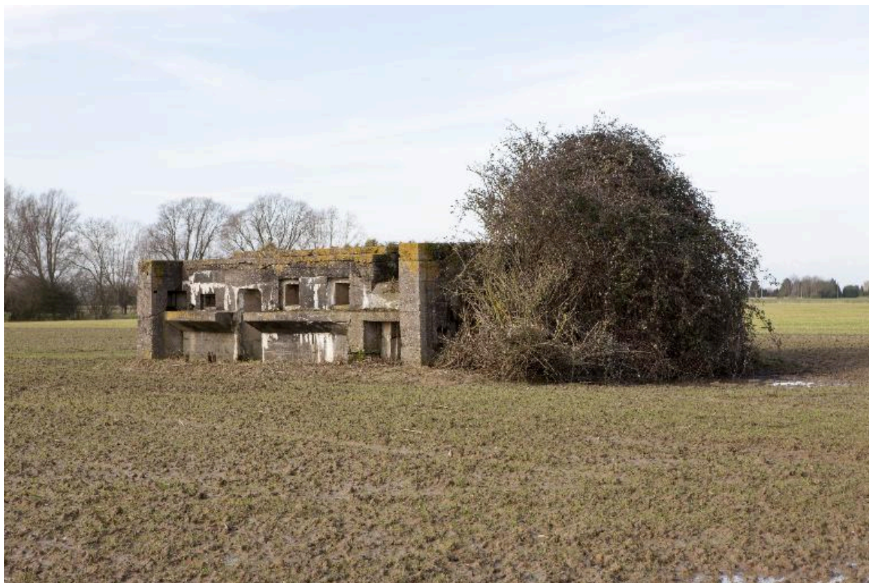
Vue générale vers le nord-ouest
