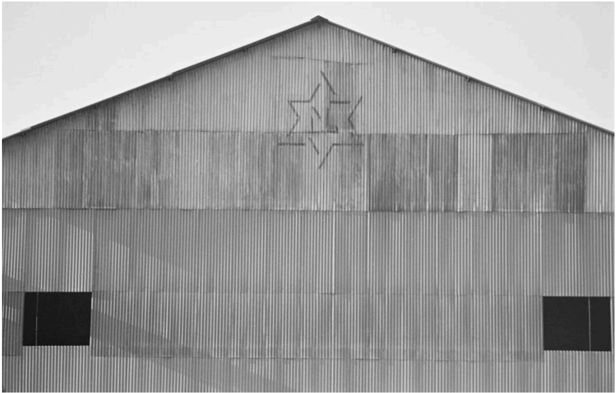
Magasin industriel : flanc est.
