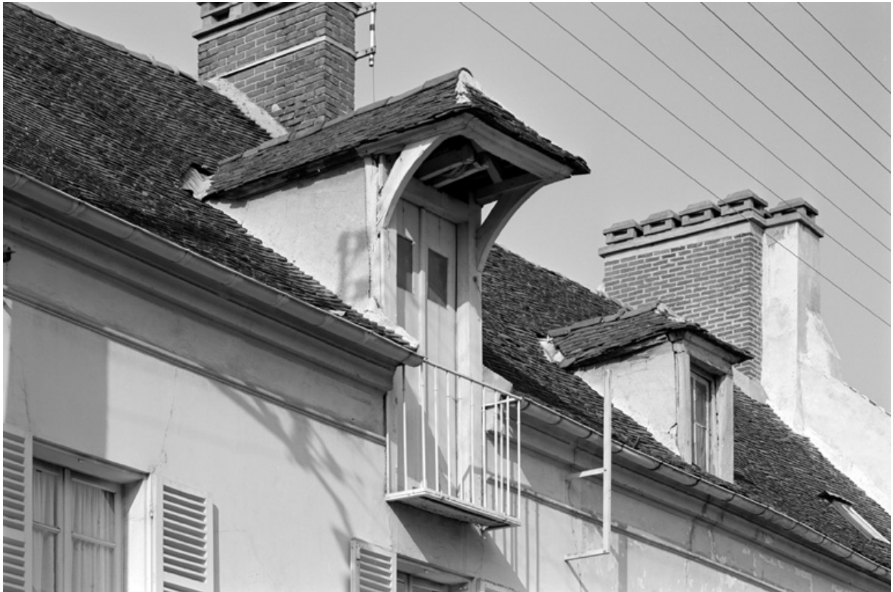
Lucarne monte-sacs surmontant la façade d'une ancienne boulangerie, 17 rue Paul Doucet.
