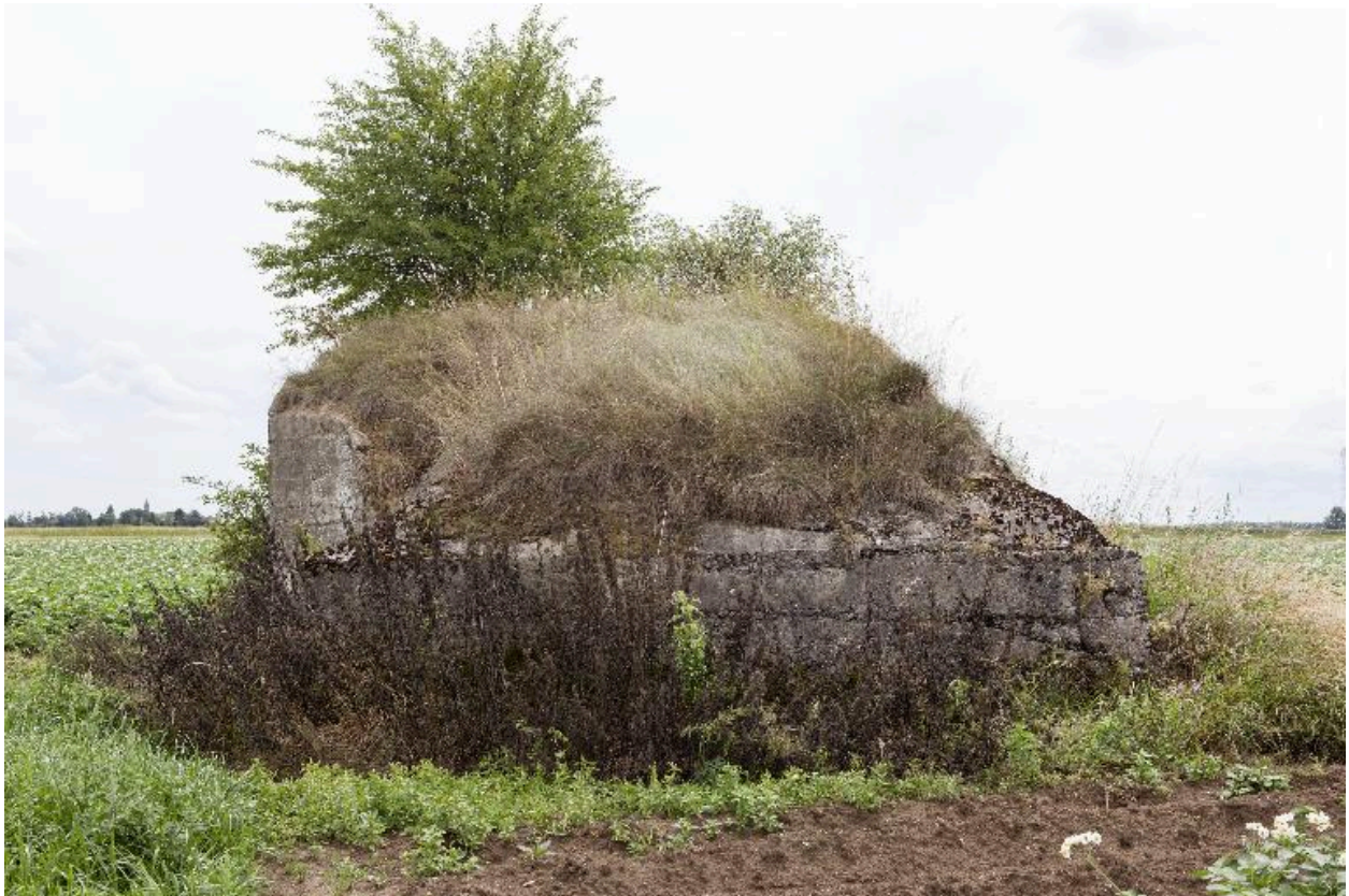
Vue latérale vers le sud
