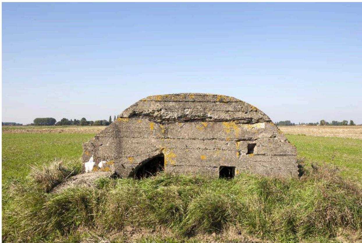
Entrée sur l'élévation sud
