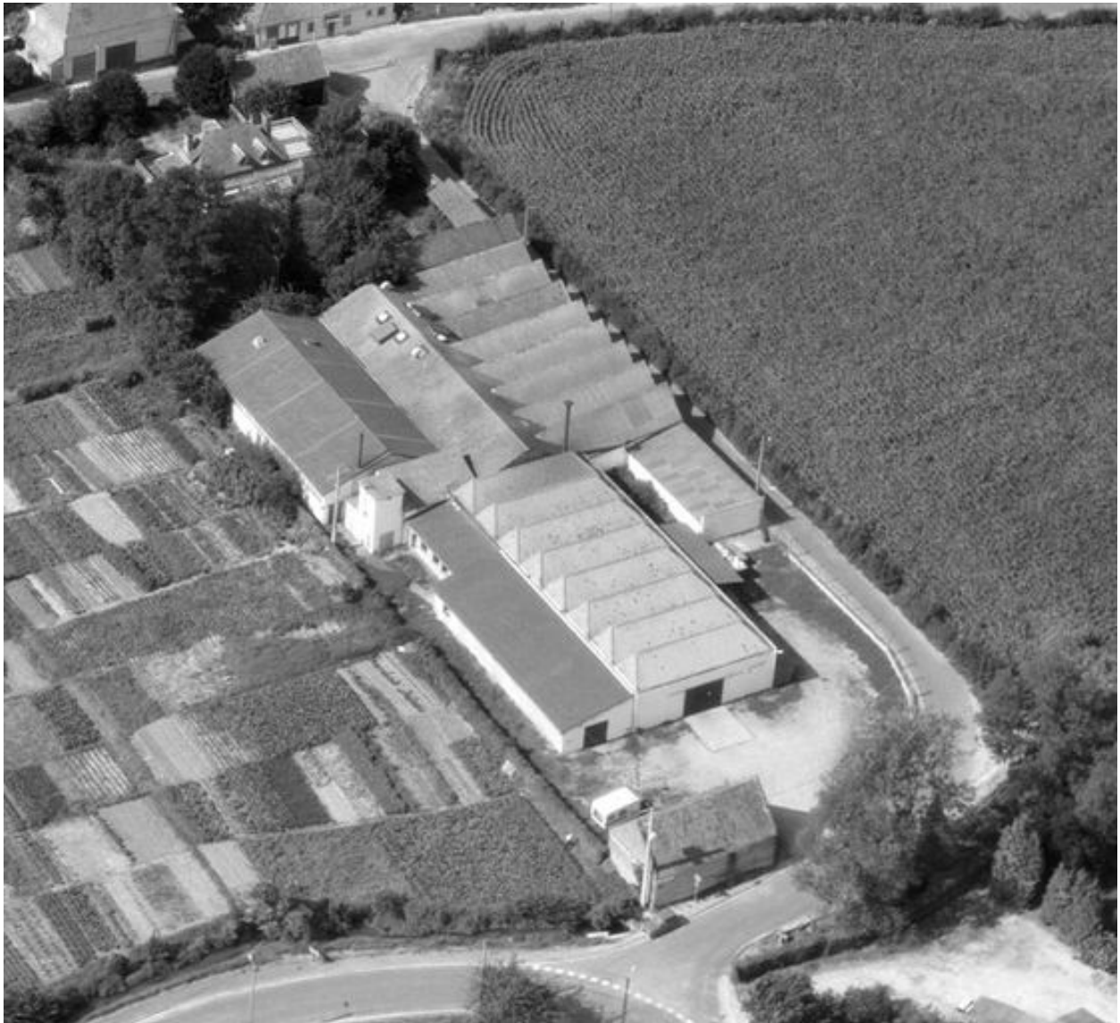
Vue aérienne, flanc sud.
