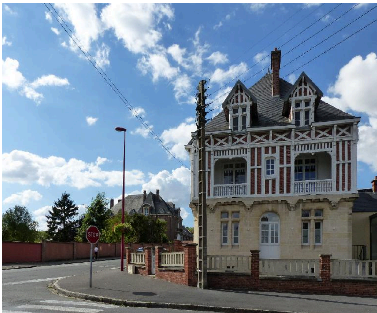
Vue depuis le sud.
