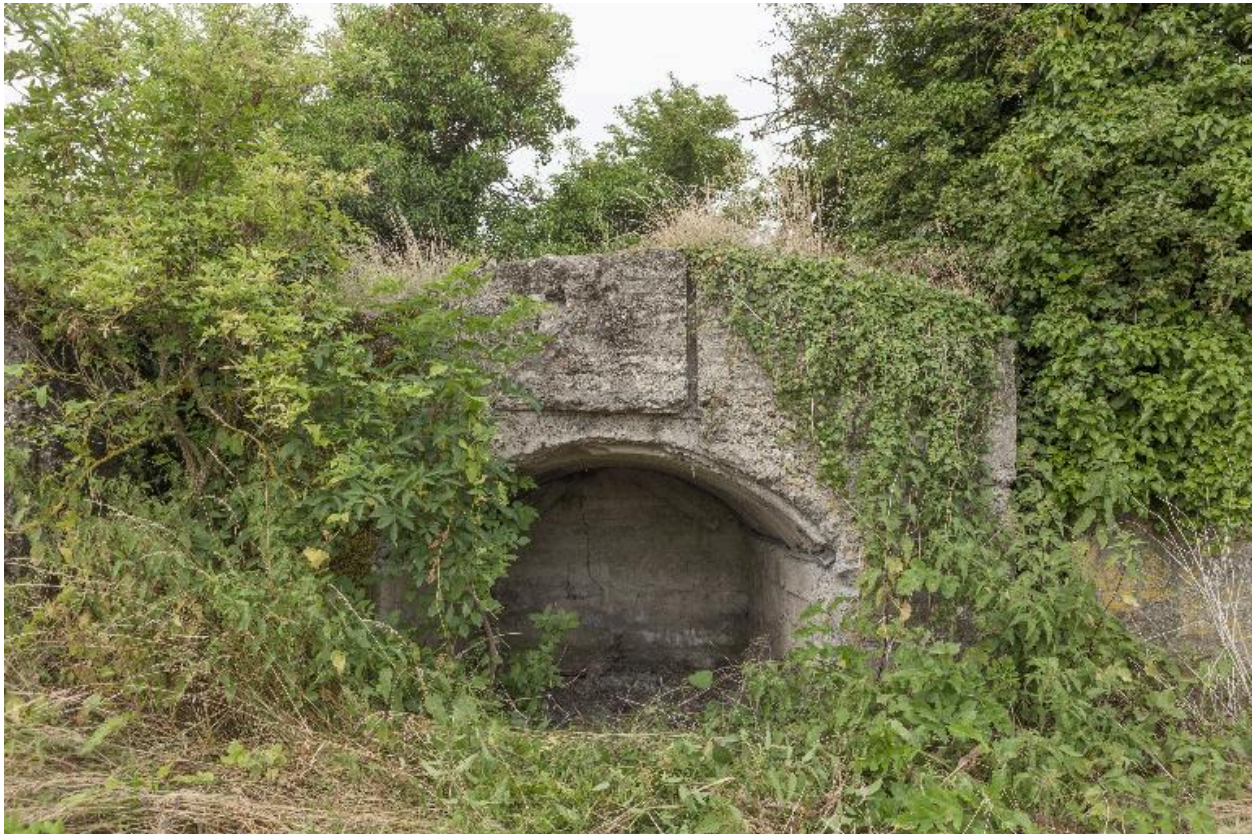
Casemate d, vers l'ouest
