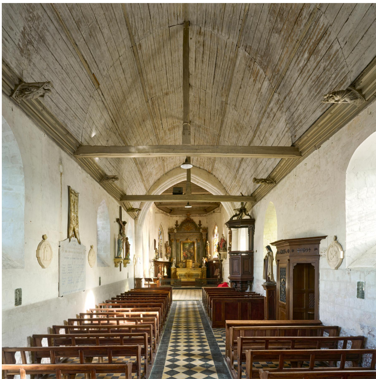
Intérieur, vue de la nef depuis le clocher.
