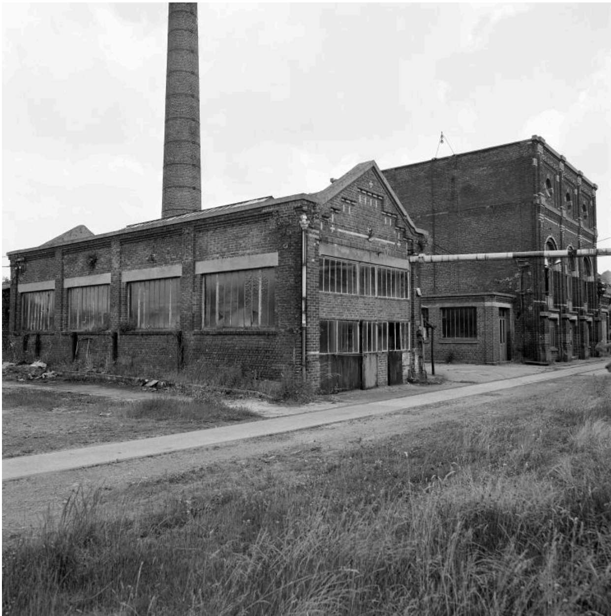
Chaufferie, à gauche, et salle des machines à droite. Vue prise vers l'est.
