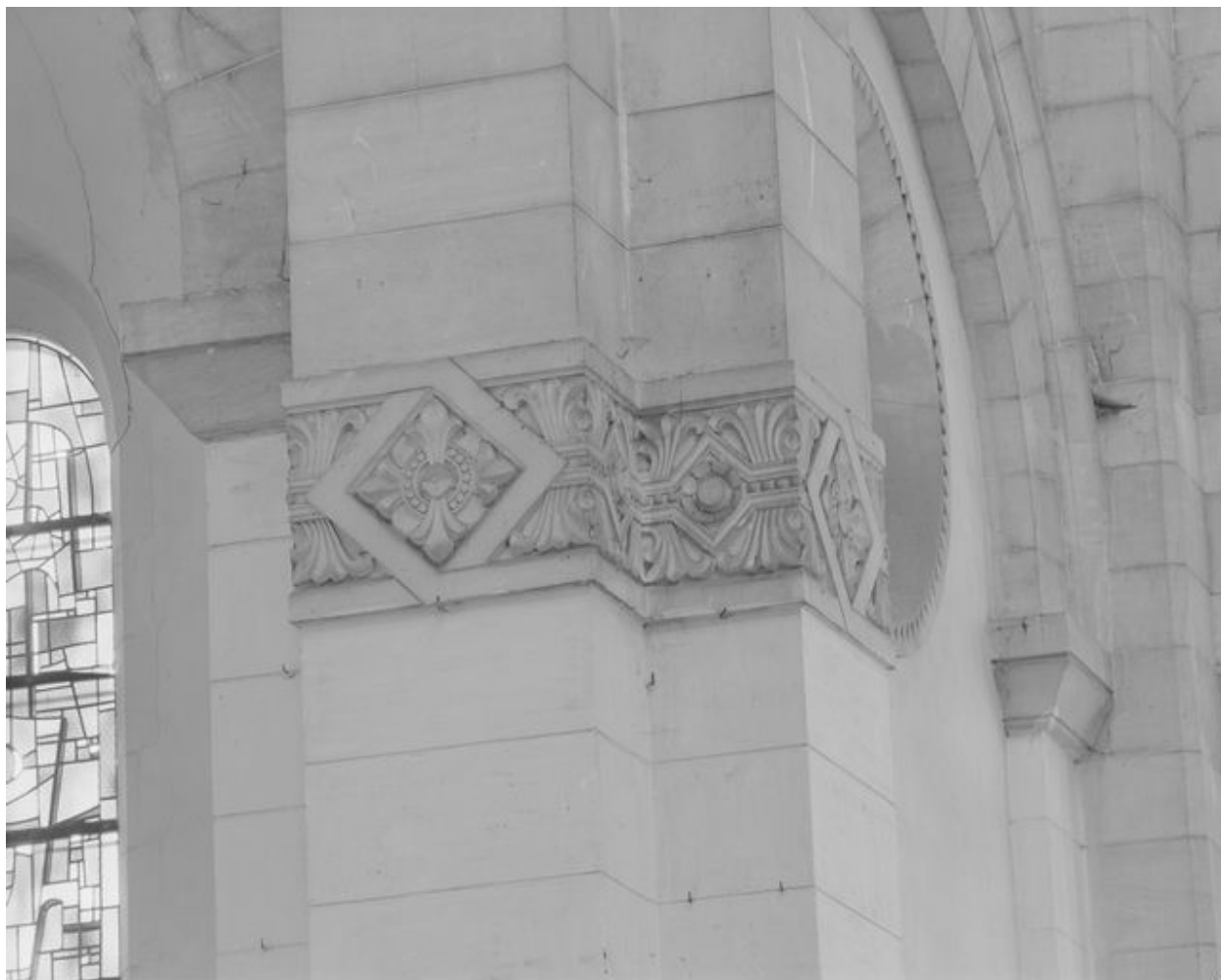
Vue de détail : chapiteau de la croisée.
