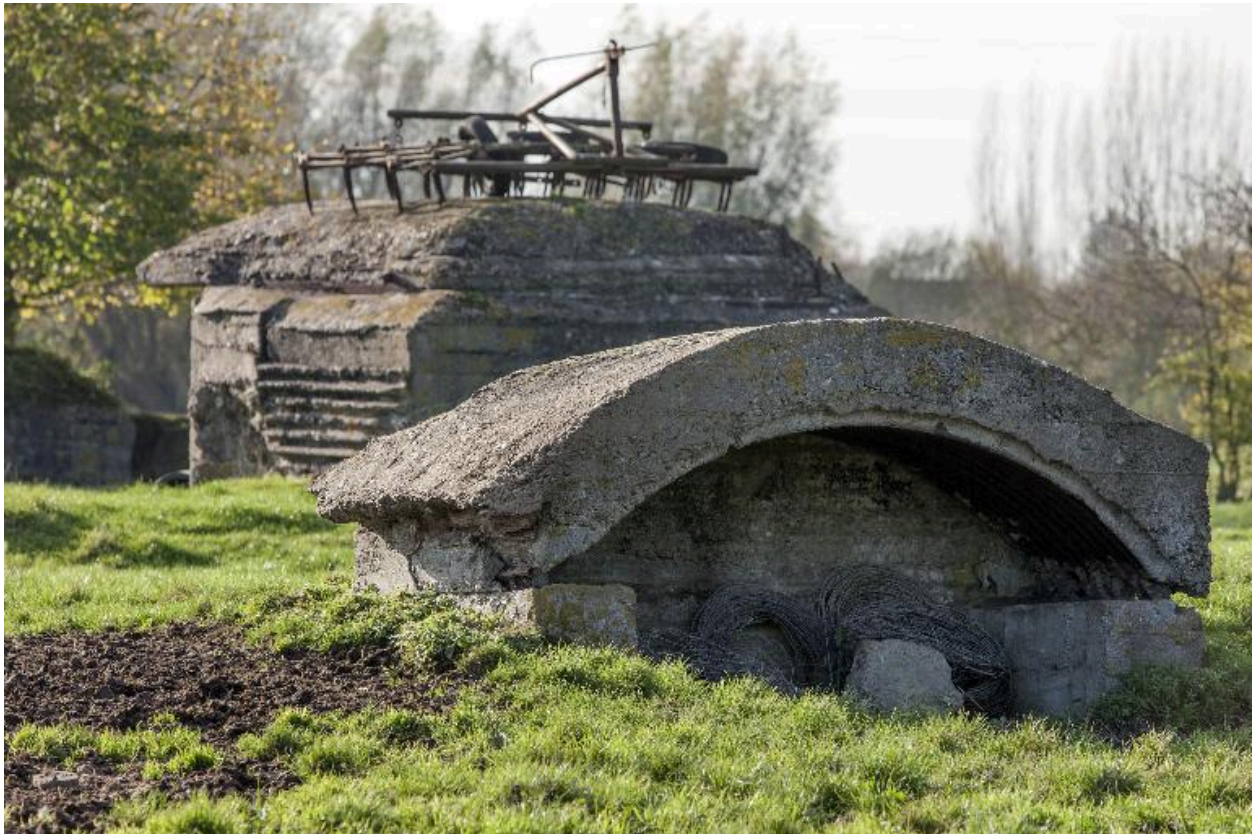
L'édifice, dans le fond, à droite en 2013
