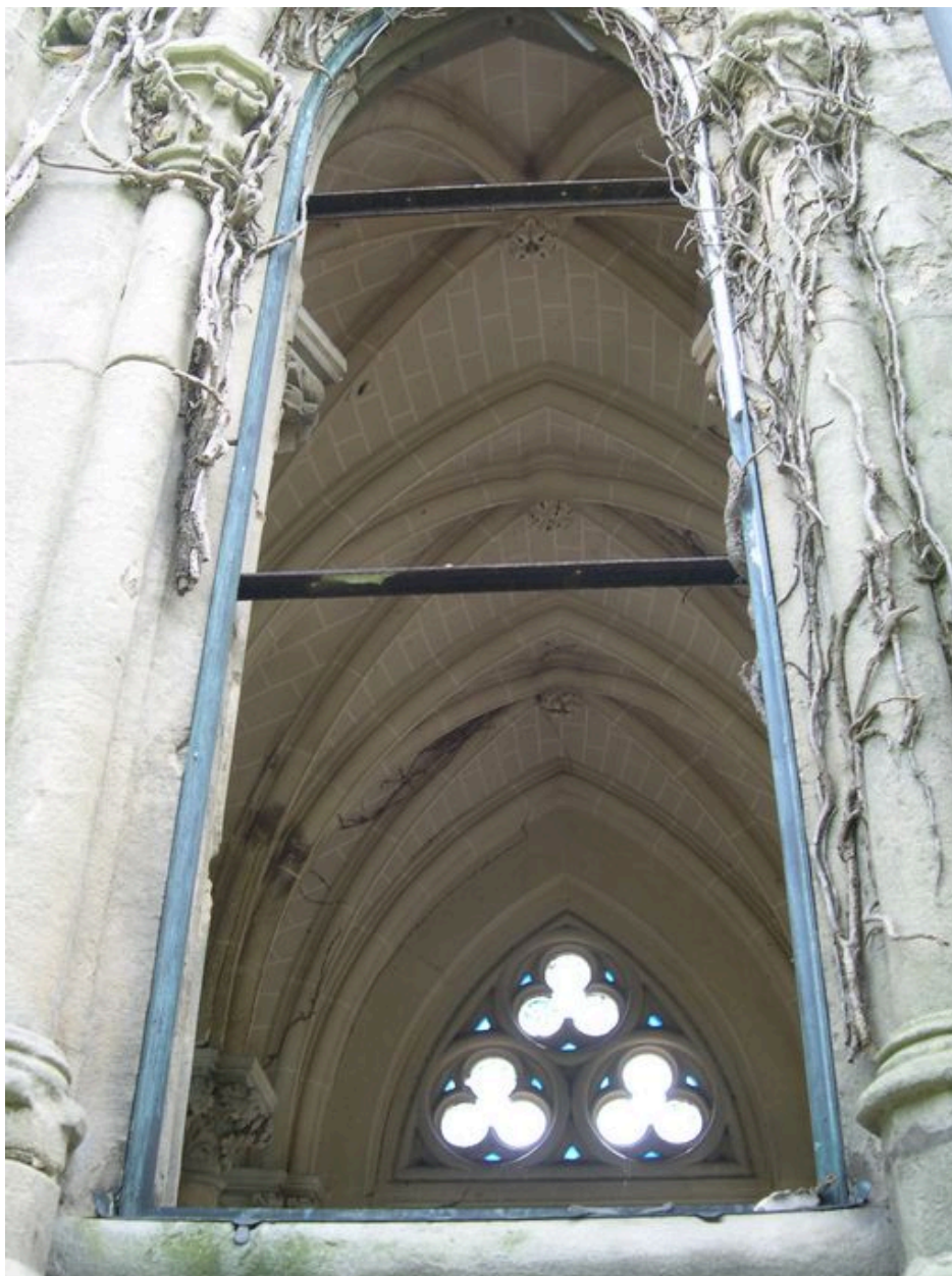
Vue de détail : voûtes.
