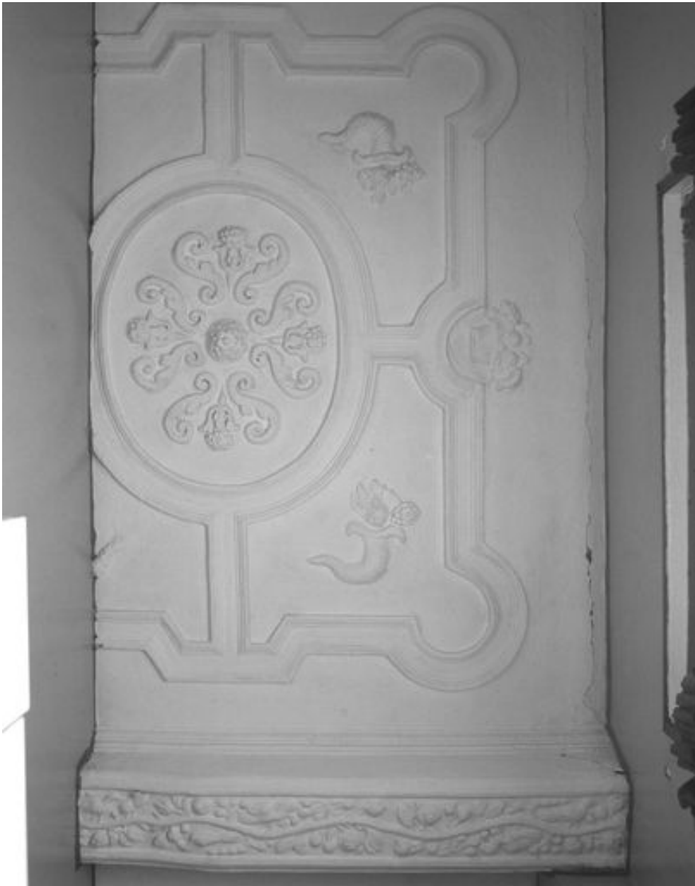
Vue partielle du plafond coupé par le cloisonnement en logements (ici, n° 37 rue de la Cavalerie).
