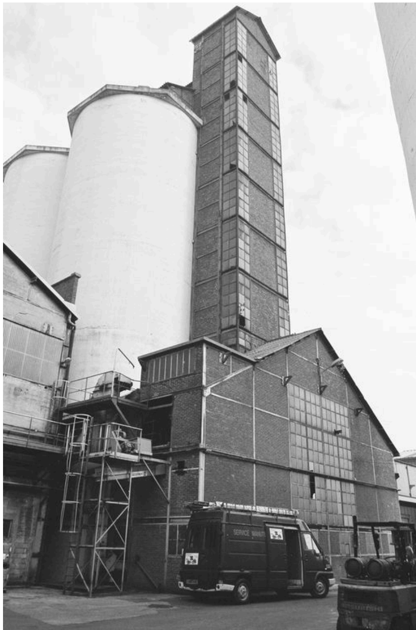
Réservoir industriel : vue partielle.
