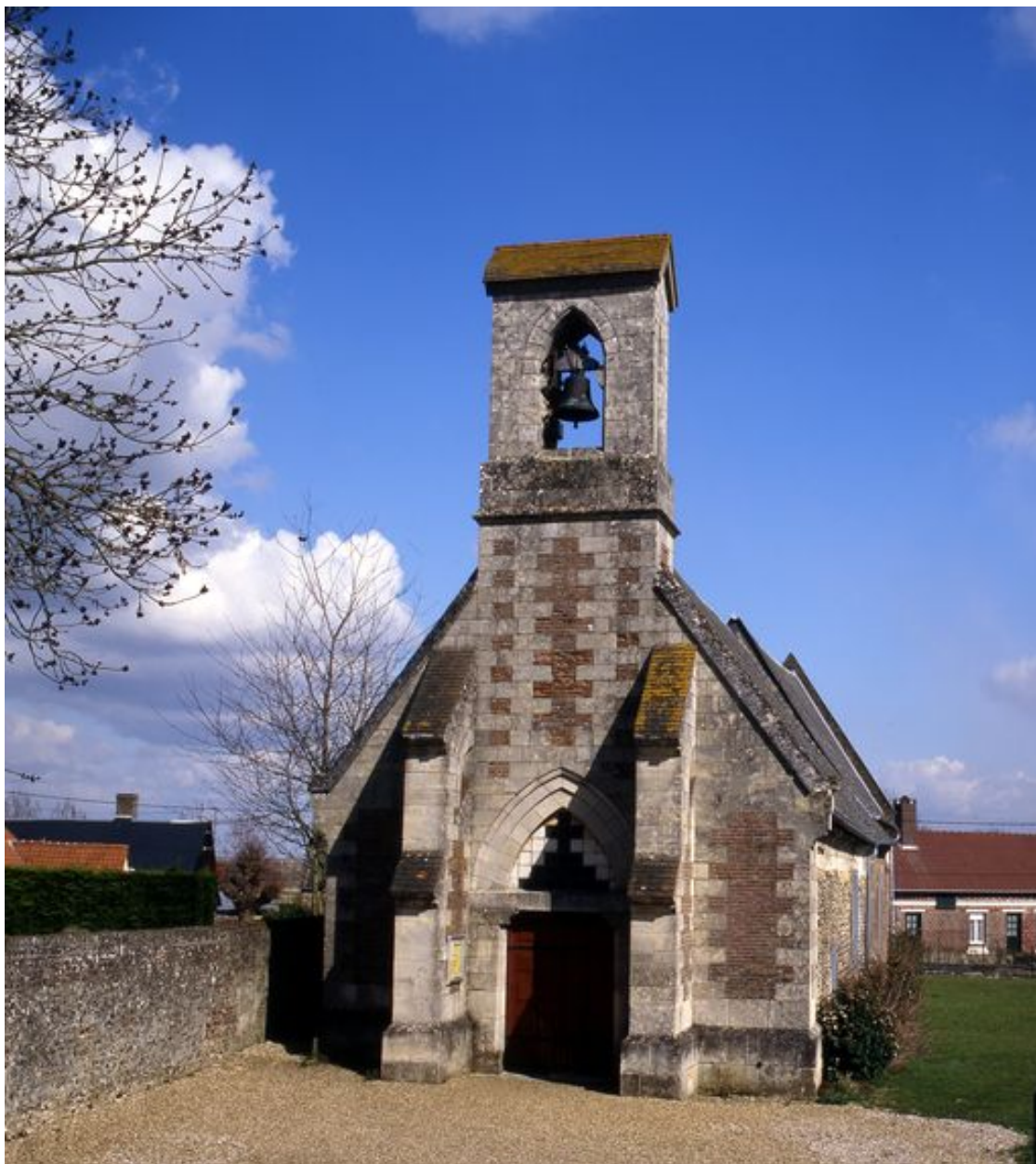
Vue de la façade ouest.
