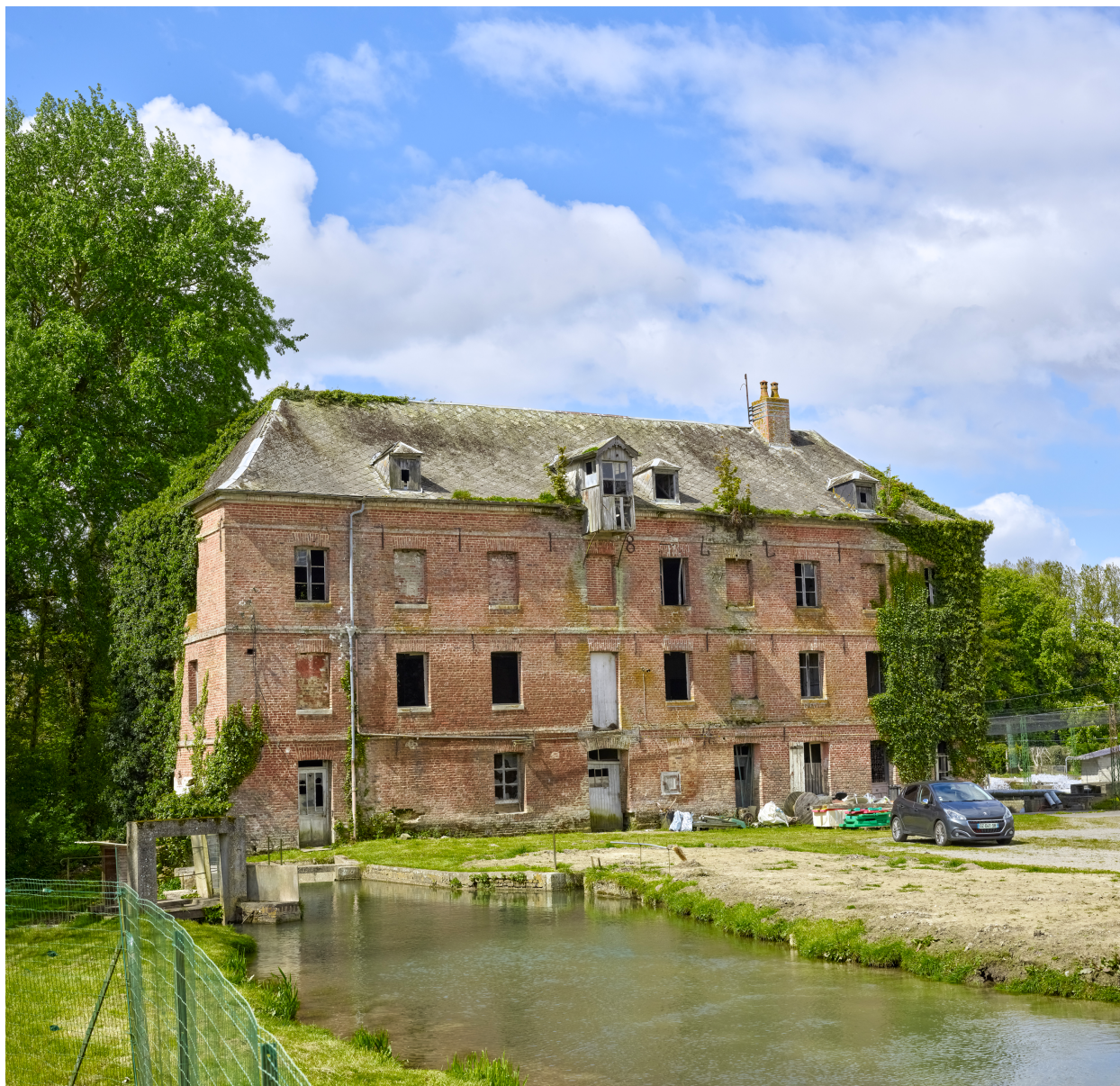
Ancienne minoterie, 1 Chemin du Grand-Pont.
