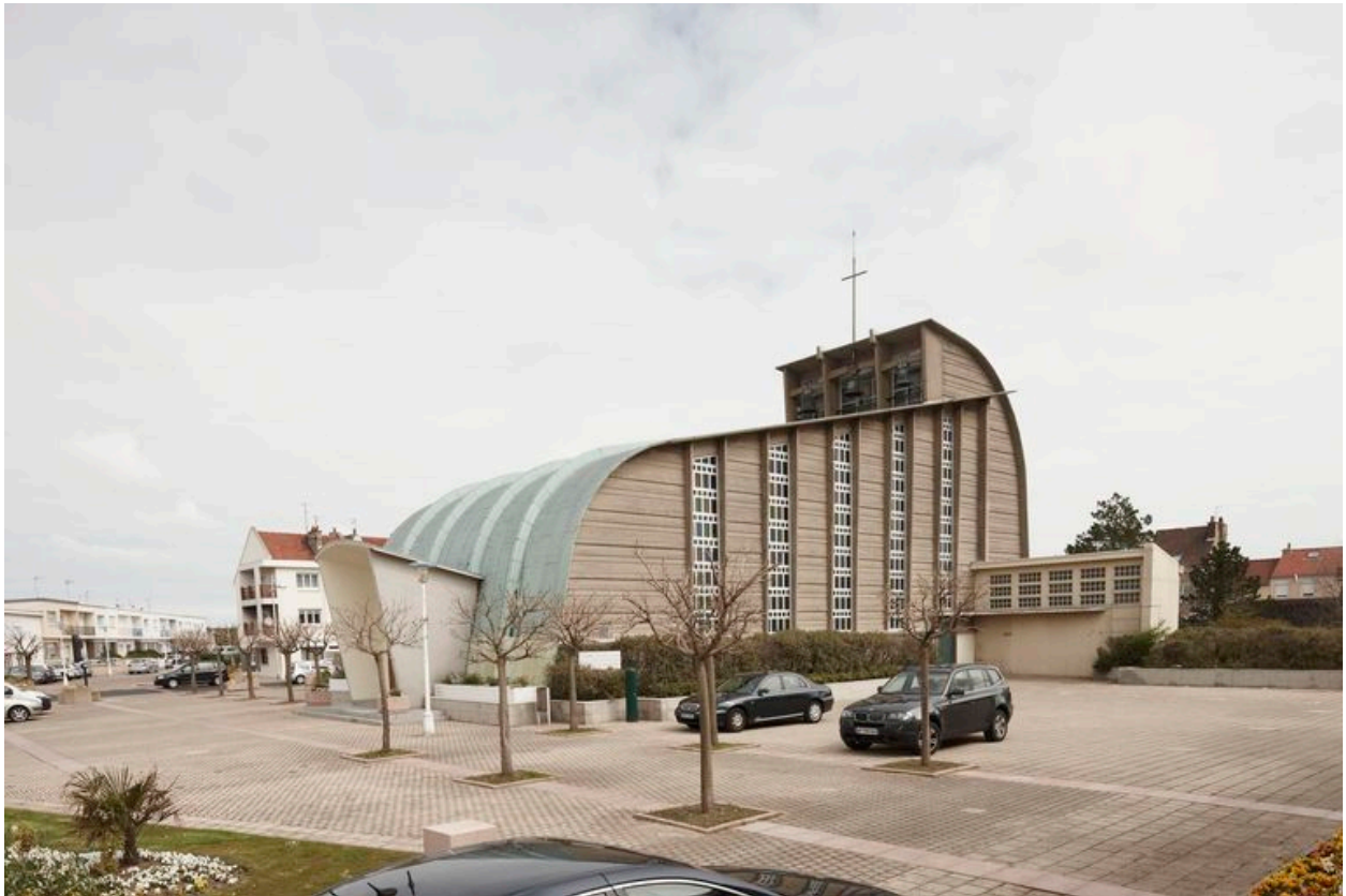
Vue de l'élévation latérale.
